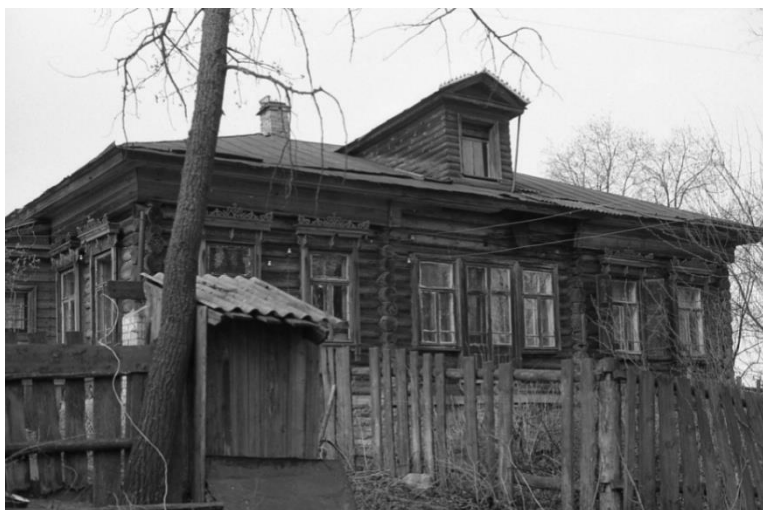
Дом Полетаевых. Южный (парковый) фасад. 1988 г. Фото А.Л. Бомзы.
